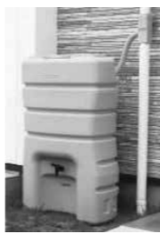
雨水貯留タンクの例
