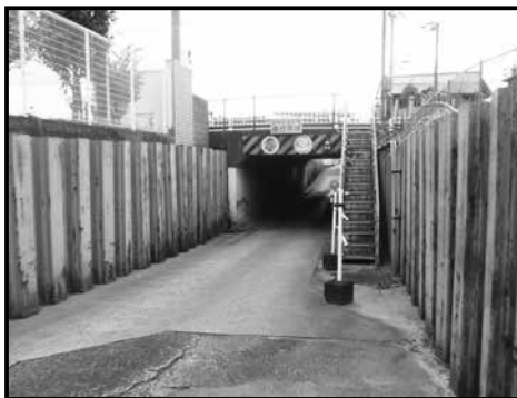
南側から北向きの遠景
