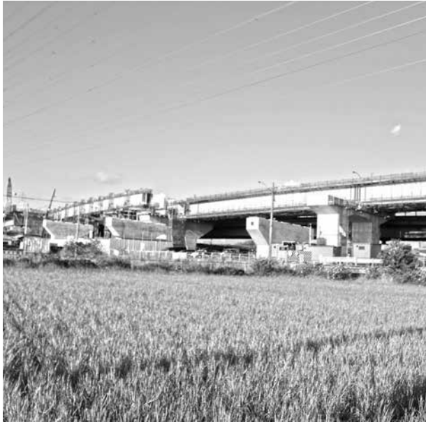
工事が進む環状2号線
