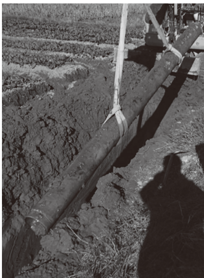
石綿管取り替え
