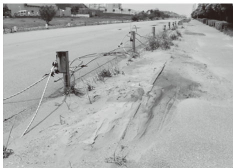
液状化で地面から砂が噴出した様子
