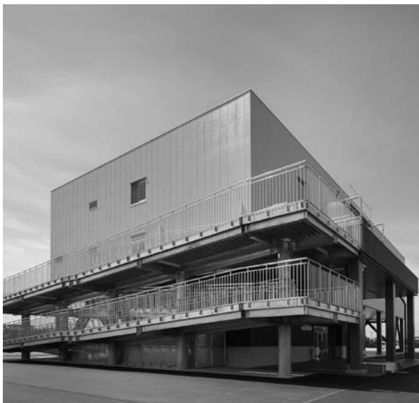
北拠点避難所 東面スロープ
