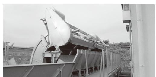
服岡排水機場のゴミを上げる機械(除塵機)
