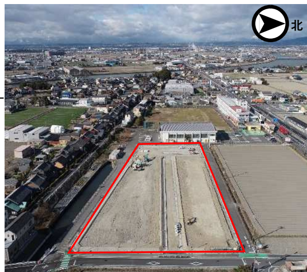
（工事の進捗状況 令和8年1月末）
