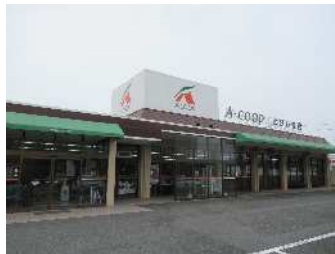
既存商業施設
