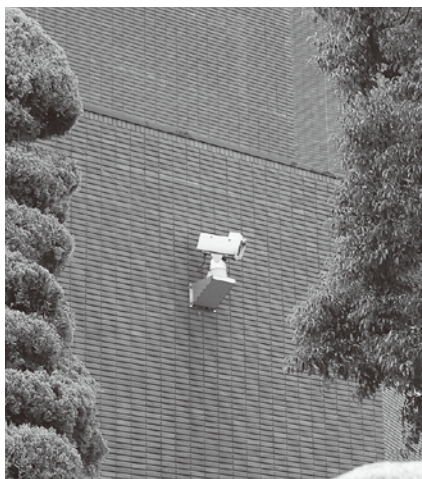
役場東駐車場のトイレを写すカメラ
