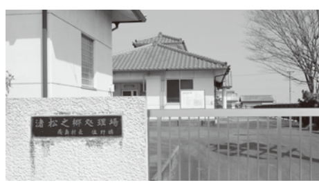
農業集落排水処理施設
