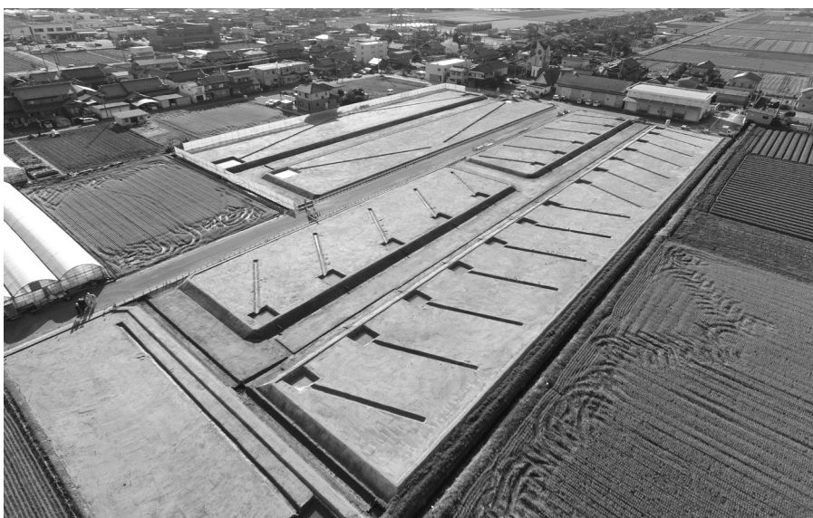
造成工事が完了した渚地区住宅地
