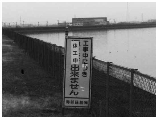
日光川堤防補強工事予定地
