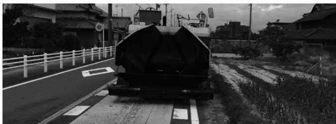
村道に駐車されたフィニッシャー(前)
