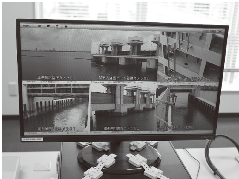
日光川排水機場の監視カメラ
