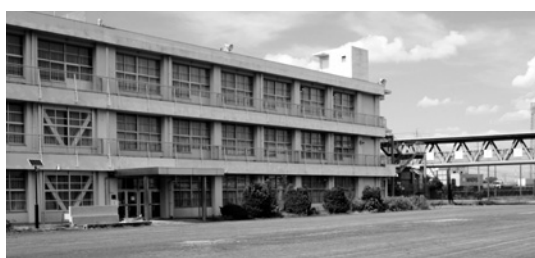
南拠点避難所の一階を使用する
