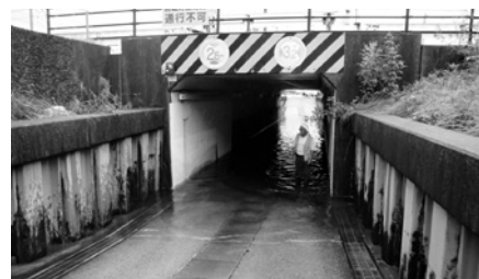
敬老センター西側のアンダーパス
