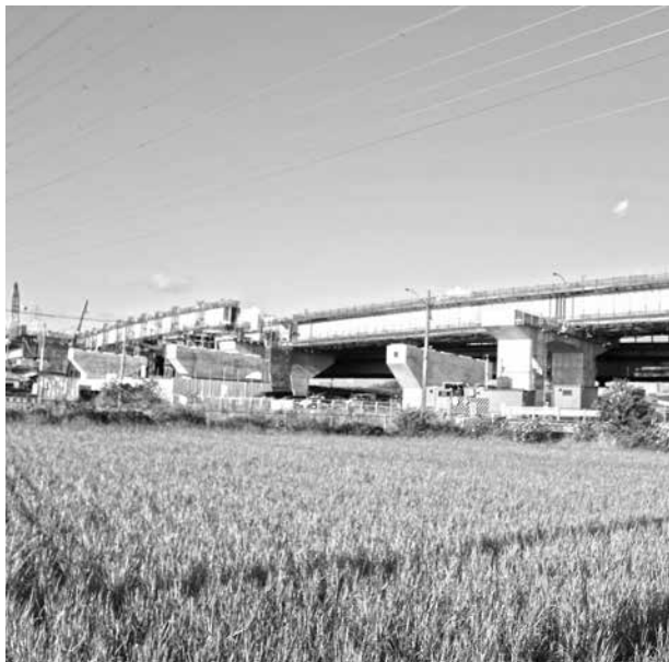
工事が進む環状2号線
