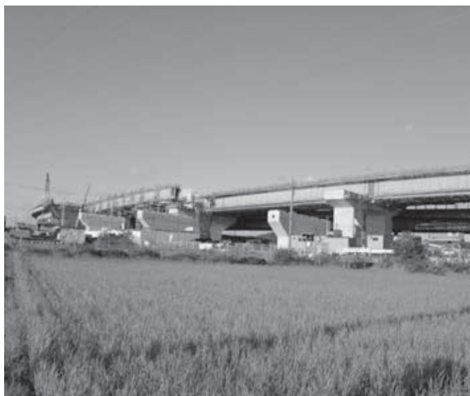
工事が進む名古屋第二環状自動車道
