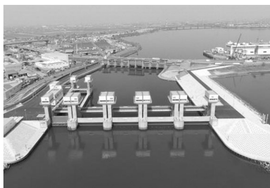
日光川水閘門
