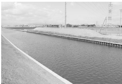
工事で発生した残土
