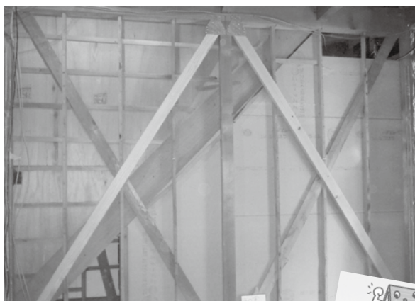
耐震補強工事(筋交いの追加)
