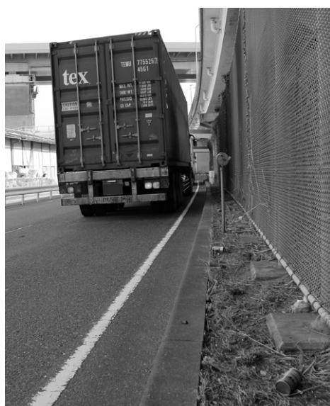
国道23号高架下のゴミ捨て
