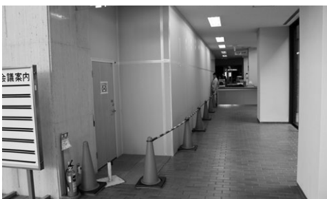
工事は南側から始まります
