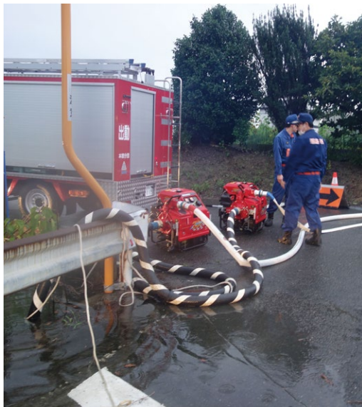
大雨により冠水した村道の排水作業の様子
