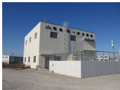
飛鳥第一排水機場
