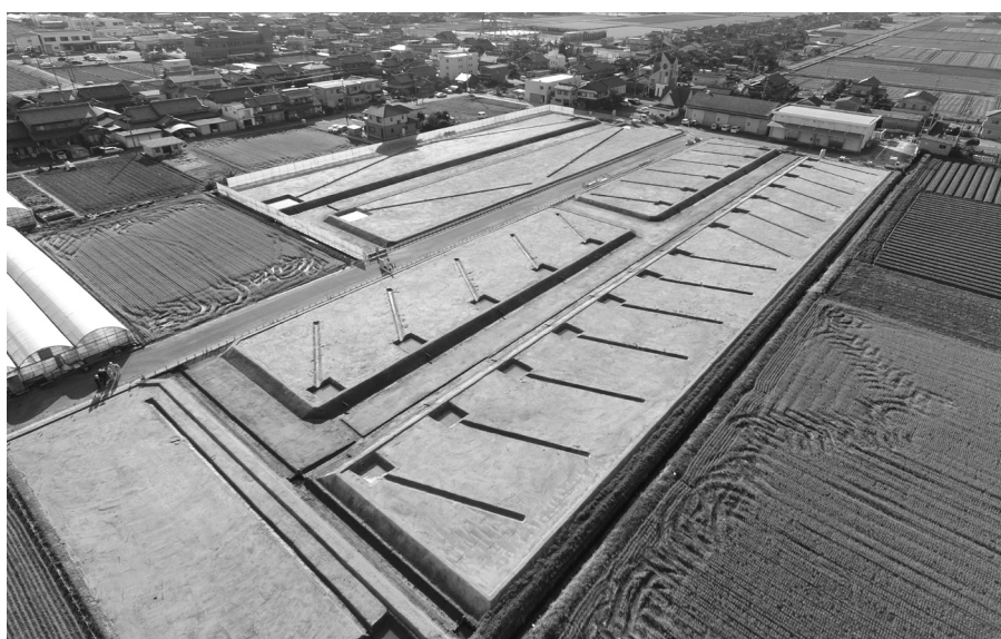
造成工事が完了した渚地区住宅地
