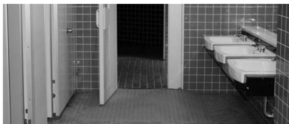
段差が解消されたホールトイレ
