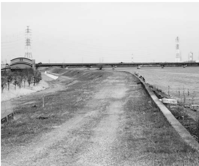
日光川右岸堤から飛島大橋を望む
