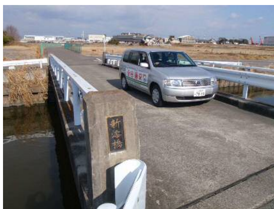
写真-3.3 道路パトロール状況
