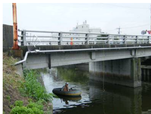
写真-3.2 専門業者による点検
