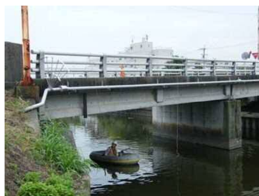
写真-3.2 専門業者による点検状況
