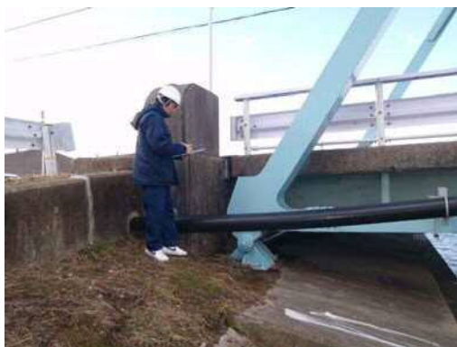
写真-3.1 職員による点検状況
